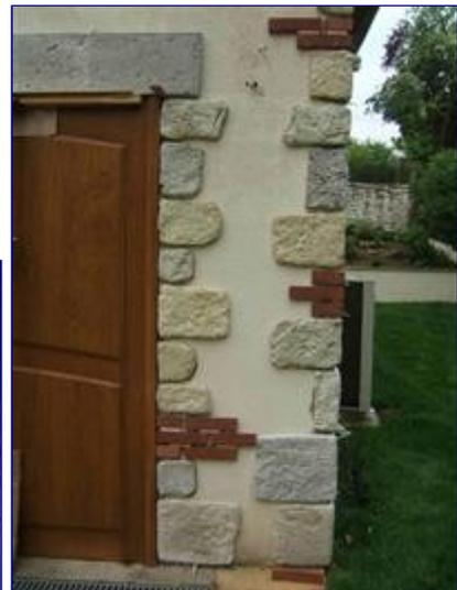
Pour des ouvertures avec linteau, commencer la pose par la partie inférieure.
