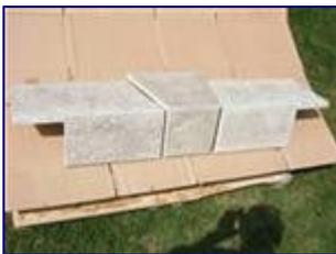
Procéder au découpage sur les traits à l'aide d'une disqueuse équipée d'un disque diamant.
